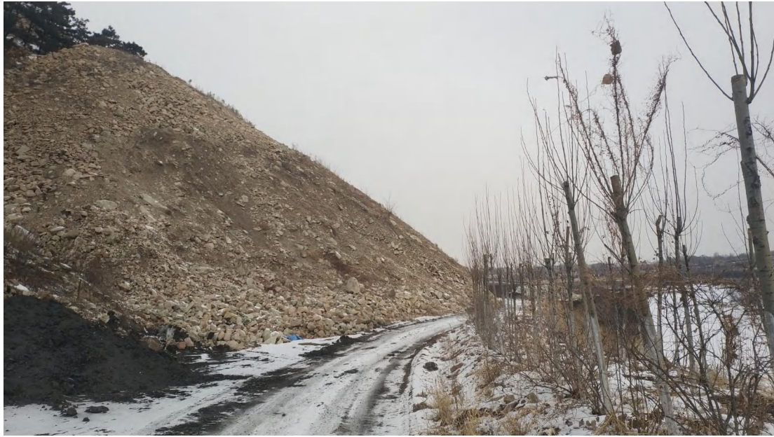
照片 1-1 矿区北侧工业广场
