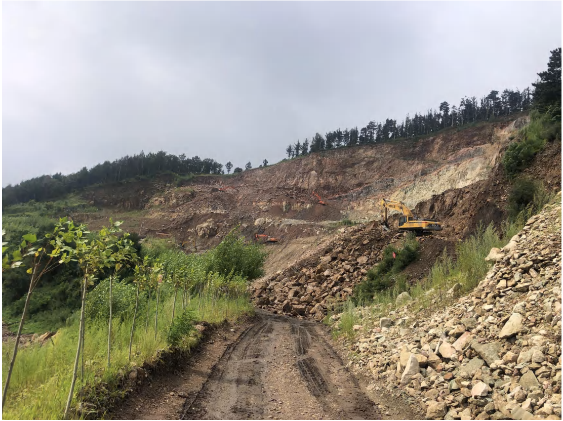
照片 1-10 矿山道路已治理区域
